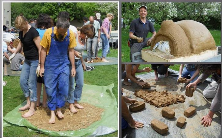
Lehmofenbau: Stampfen, Ziegelkneten, rechts oben einer der fertigen Öfen.
